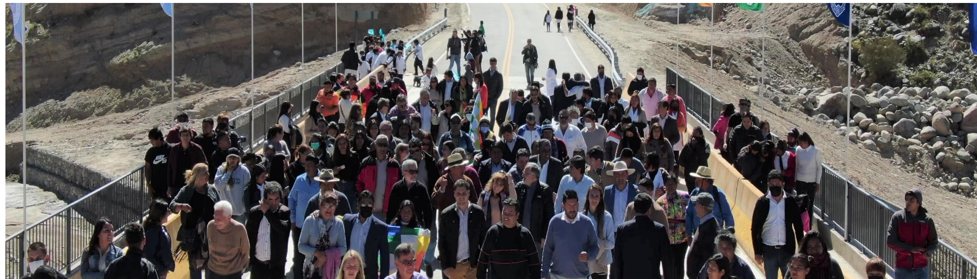
アルゼンチン・インフラ・トラストが資金提供したカタマルカ州の道路橋の開通式が行われました。
